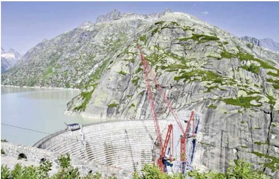
Die Kräne beim Grimselsee müssen Windspitzen von 220 Kilometern pro Stunde und auch Schneestürmen standhalten.
